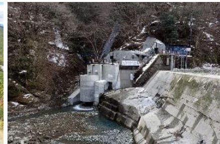
湘南ベルマーレ早戸川発電所 (小水力)
