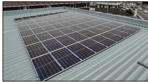
和歌山支社伏虎営業部 屋上
