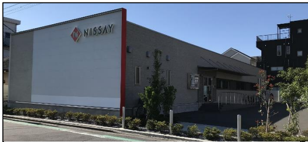
さいたま支社川口営業部 外観
