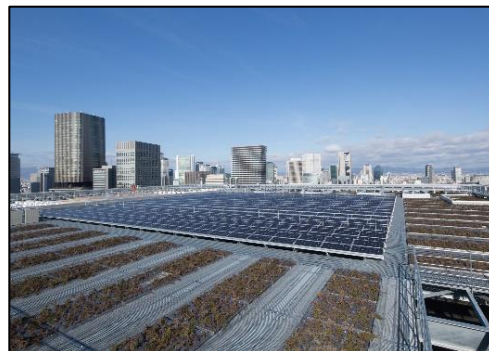
大阪本店東館 屋上
