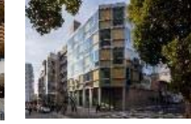
兵庫県林業会館 地上5階 延床 1,567㎡ 兵庫県神戸市
