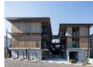
アサヒファシリティズ 山門町寮 葵 地上3階 延床 474㎡ 名古屋市
