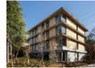
竹中研修所 匠 新館 地上3階 地下1階 延床 1,209㎡ 兵庫県川西市
