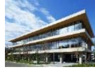
新柏クリニック 地上3階 延床 3,132㎡ 千葉県柏市
