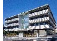
公道会病院 地上5階 延床 5,584㎡ 大阪市
