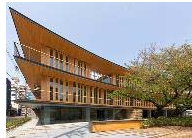
大阪木材仲買会館 地上3階 延床 1,032㎡ 大阪市
