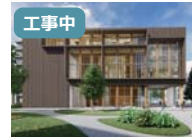
URまちとくらし のミュージアム 地上4階 延床 1,820㎡ 東京都北区
