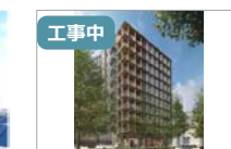
ウッドライズ仙台 地上10階 延床 10,191㎡ 宮城県仙台市
