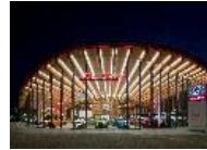
愛知トヨタ 高辻店ショールーム 地上4階 延床 4,321㎡ 名古屋市
