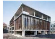
横浜商科大学 高等学校実習棟 地上4階 地下1階 延床 1,987㎡ 横浜市
