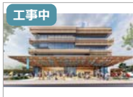
守山市庁舎 地上4階 延床 13,492㎡ 滋賀県守山市
