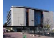
FOREST GATEWAY CHUO 地上6階 延床 12,718㎡ 東京都八王子市
