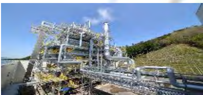
真庭バイオマス発電所
