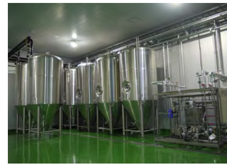
缶ビール製造機器の設置
