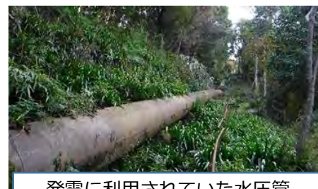
発電に利用されていた水圧管
