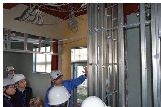
建設業現場の責任者から説明
